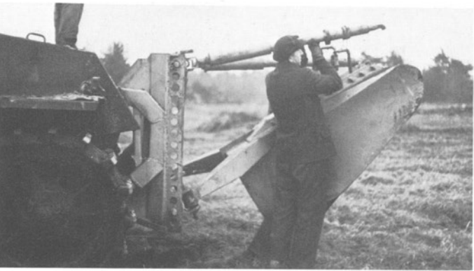
Die Druckstangen werden eingelegt.
