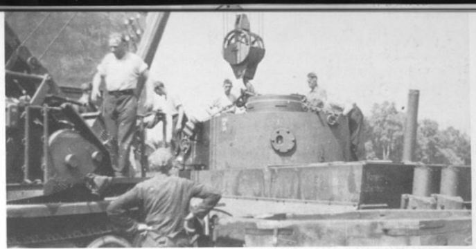
Turmabnahme beim ersten VK. 4501 Versuchsfahrzeug in der Henschel Erprobungsstelle Haustenbeck i. L.
