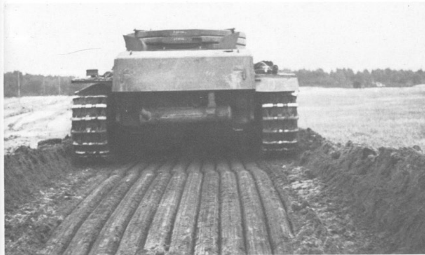
Trotz erheblicher Erdbewegung hat sich das Fahrzeug noch kaum eingegraben.
