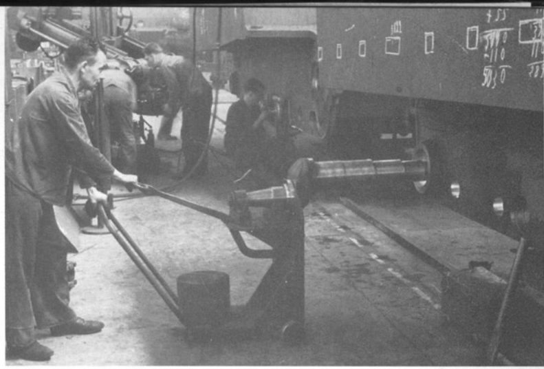
Der Einbau der Leitradkurbel auf der Montagestraße.
