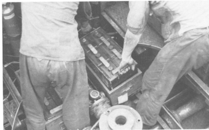
Hier wird eine Batterie dem Heizkasten entnommen.
