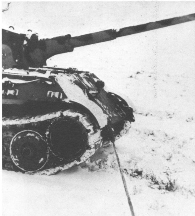
Eine Bugschleppöse wurde geschaffen, um ein Fahrzeug beim Abschleppen seitlich herumziehen zu können.
