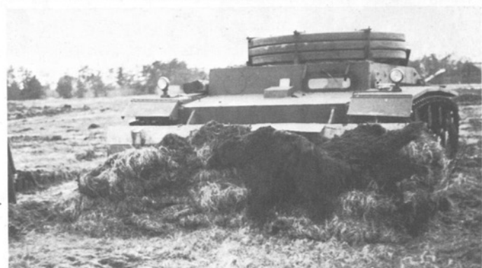
Das Fahrzeug VK. 3001 (H) mit vorgebauter Panzer- eingrabevorrichtung.
