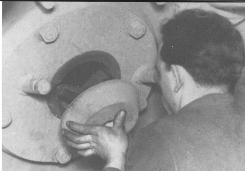
Die große Wartungsklappe im Heckblech war zweiteilig ausgeführt.
